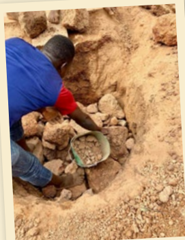
Au fond dépôt de 50 cm de graviers, puis des gros cailloux et encore du gravier
