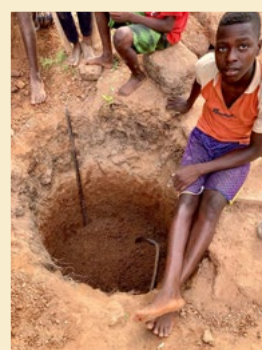
Au fond dépôt de 50 cm de graviers, puis des gros cailloux et encore du gravier
